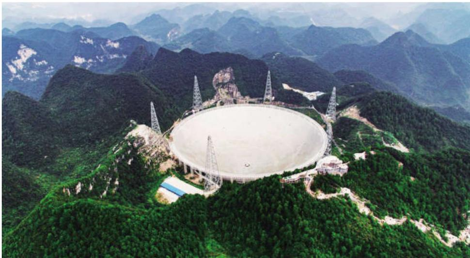
2016年9月25日,有着“超级天眼”之称的500米口径球面射电望远镜(FAST)在贵州平塘喀斯特洼坑中落成启用。
